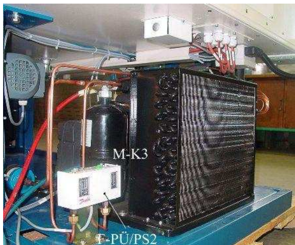
Компрессор холод. уст. 3 (ТЕПЛОКАМЕРА II)
